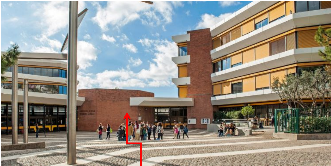
Fachada donde estará la obra de arte
